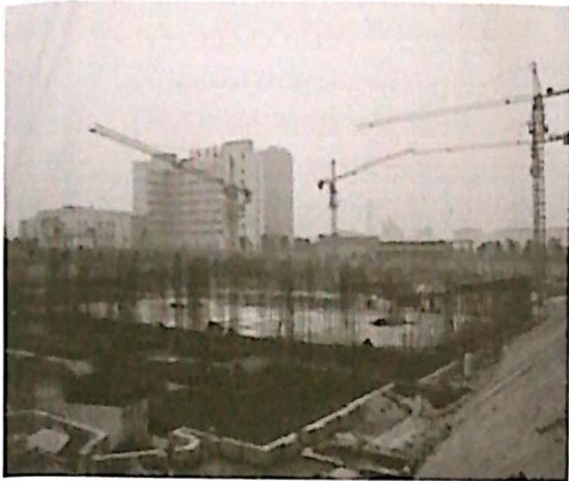
图1 流水施工现场作业
